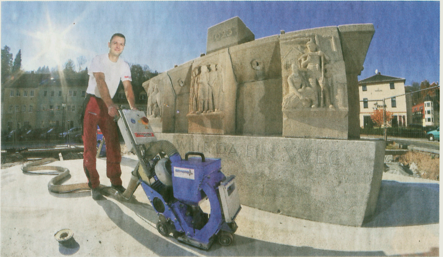
Thomas Janick von der Reinholdshainer Firma Flammstrahltechnik Zöltsch bearbeitet den Betonuntergrund für das künftige Wasserbecken des Glashütter Stadtbrunnens mit einer Kugelstrahlmaschine. Damit werden die Poren im Beton geöffnet.
